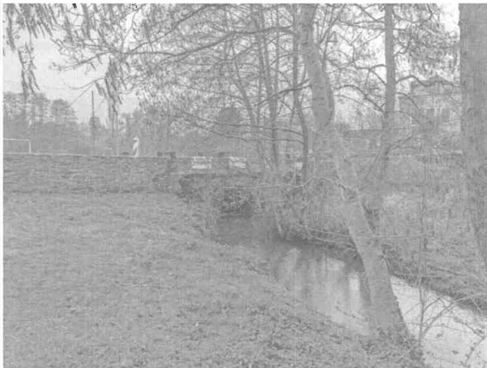
Emplacement préférentiel des gîtes artificiels à chiroptères en amont du pont
